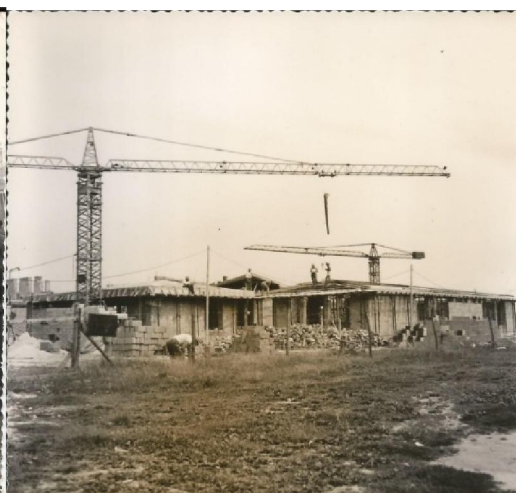
cantiere per la costruzione del nuovo Asilo
